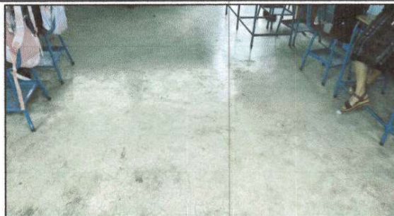
FOTO 2: Sustitución de piso de torta de concreto por piso cerámico.
